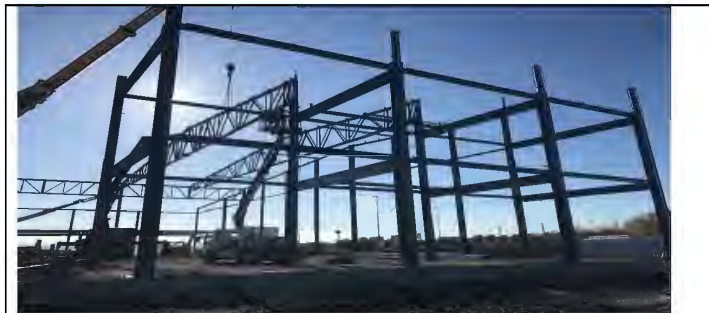
FASE ACTUAL EJECUCION OBRA -- MONTAJE ESTRUCTURA - CATMAN NORTH, S.A.
