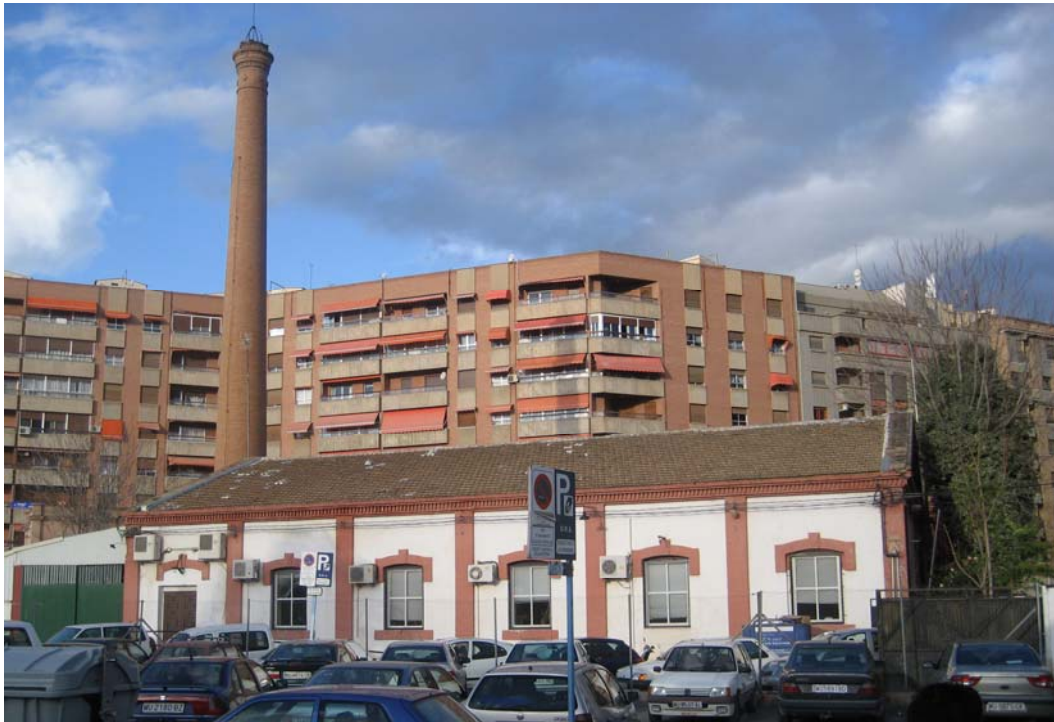
Vista lateral de las naves y la chimenea
