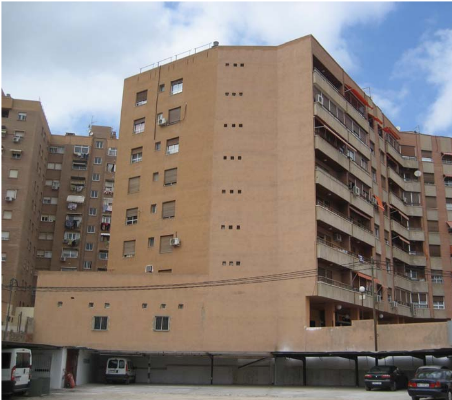
Vista de ventanas en pared propia y patio de luces abierto, de edificio lindante a las propiedades incluidas en el ámbito del PERI-3.
