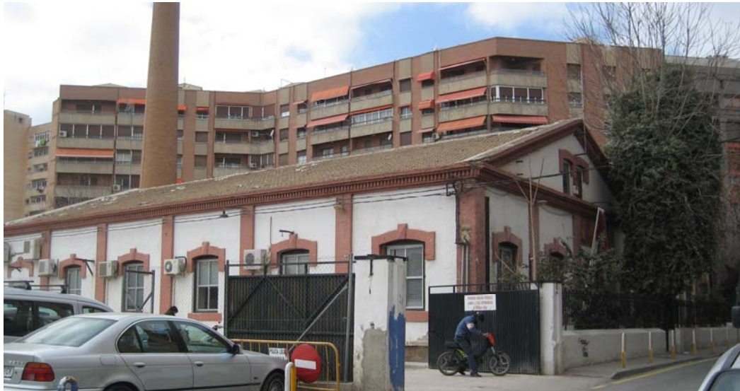
Vista lateral de las naves
