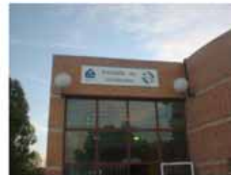
Iluminación y señalización en acceso
