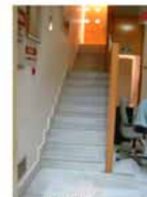
Escalera de planta acceso a primera: arranque
