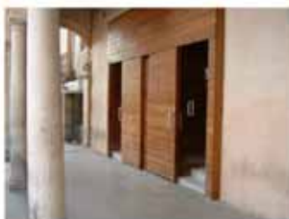
Acceso principal al edificio
