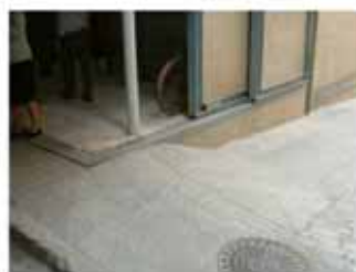
Acceso secundario: desnivel
