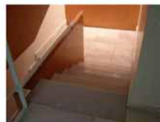
Escalera de planta acceso a primera: meseta
