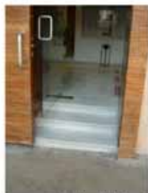
Acceso principal: peldaños
