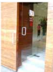
Acceso principal: puerta
