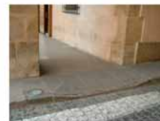
Pasaje Calle Paradores Selgas: vado peatonal
