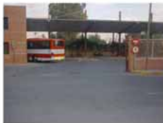
Vista de los andenes
